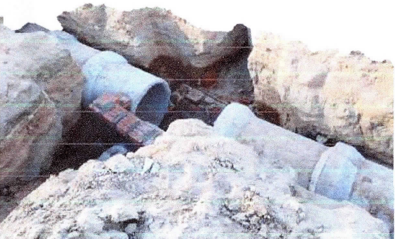
Implantação de rede de drenagem na Rua João Pequeno Romano
