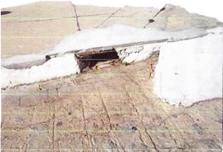
Boca de lobo na Rua São Sebastião
