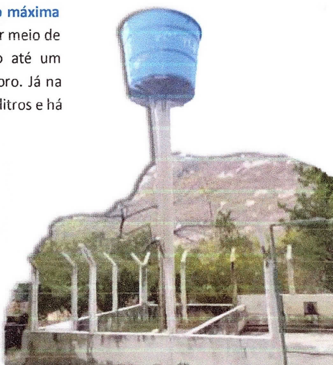
Reservatório na comunidade de Casa da Pedra
